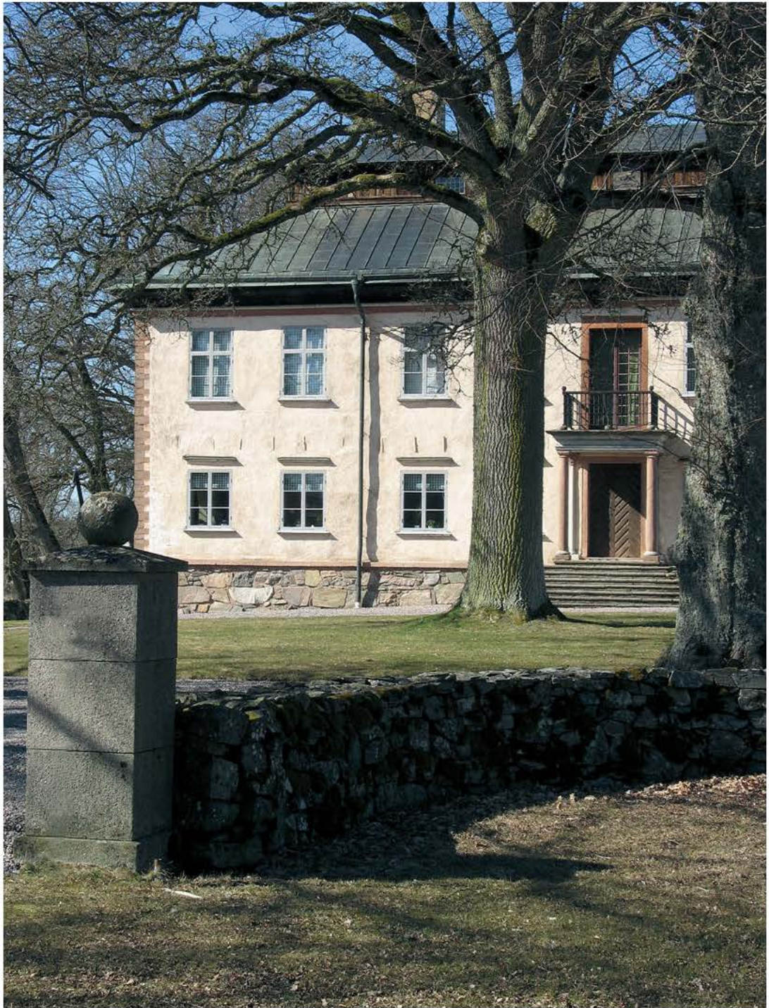
FIGUR I. Exteriör av manbyggnaden på Stola. Dagens varmt brutna puts, den exponerade naturstenssockeln, säteritaketets kopparplåt, den helglasade balkongdörren och bottenvåningens fönsterbågar är ett resultat av Erik Lundbergs restaurering 1949–1951. Foto författaren.
