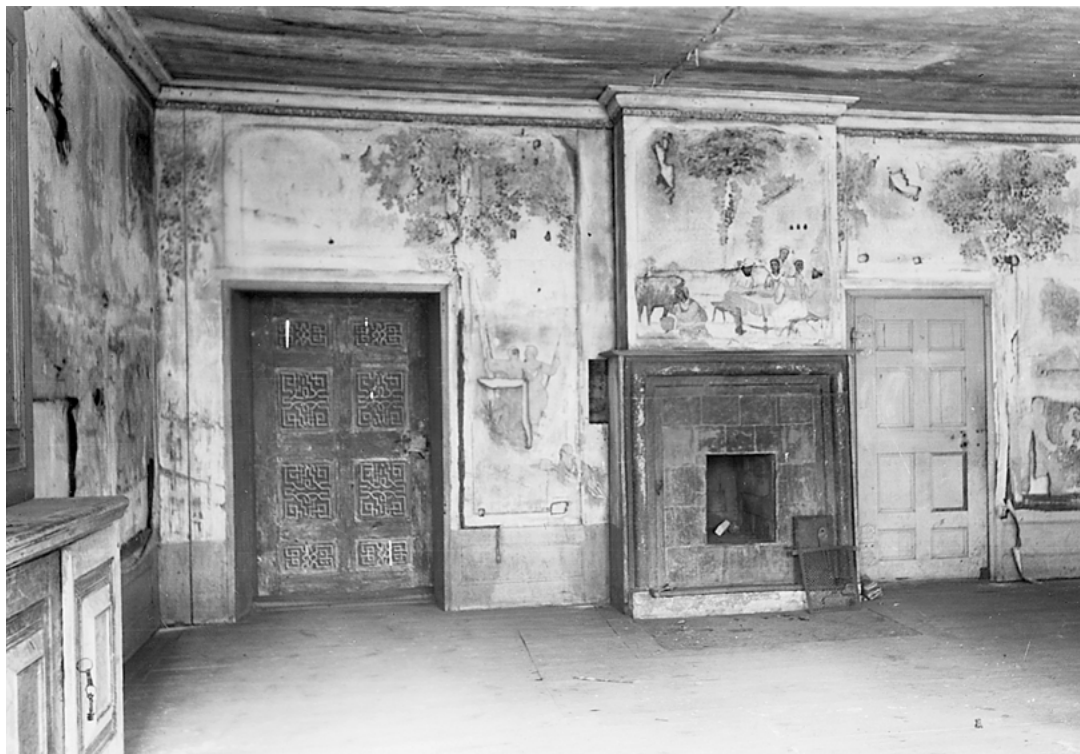
FIGUR 4. Stora matsalen före Alfred Nilsons konservering. Takmålningen var till stor del överstruken med grå färg, vävtapeterna var mycket medfarna och den öppna spisen hade en kakelugnsinsats. Foto i Alfred Nilsons arkiv, ATA.
