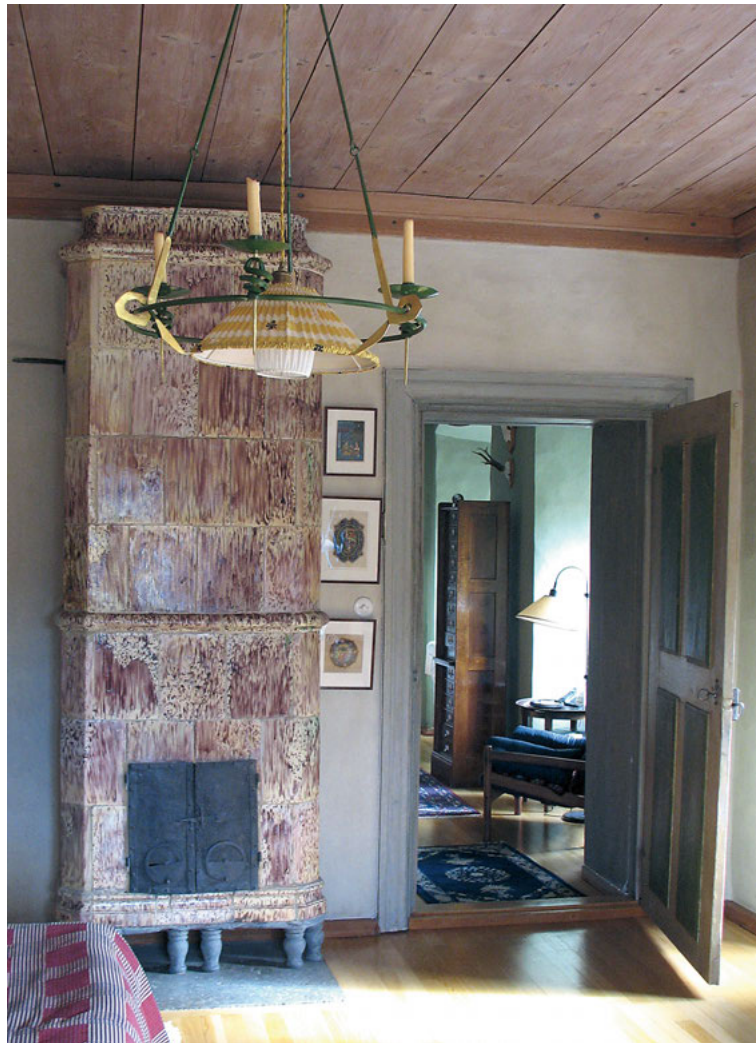
FIGUR II. F.d. biblioteket på nedervåningen är representativt för hur Lundberg hanterade den nya bostadsdelen. Rummet var förändrat av familjen Otterström och nyttjades som sovrum. Väggarna bar en storblommig tapet, golvet var belagt med maskinsågade smala brädor och korkmatta, taket vävspänt. Kakelugnen är från 1700-talets senare hälft. Lundberg lät ta fram och förnya väggarnas putsyta i en varmt bruten kulör. Takets ursprungliga trärena brädor exponerades. Golulister nygjordes. De vitmålade dörrarnas äldre dekormåleri skrapades fram. Som moderna accenter tillkom parkettgolv och synliga radiatorer. Den av Lundberg ritade takarmaturen hängde tidigare i lilla matsalen och fyllde där samma syfte. Foto författaren.
